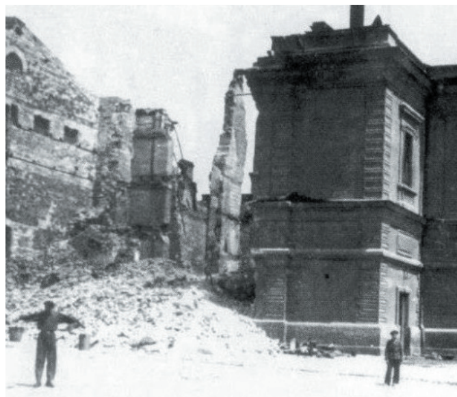
Разрушенное здание Херсонского городского театра (1944 г.)
